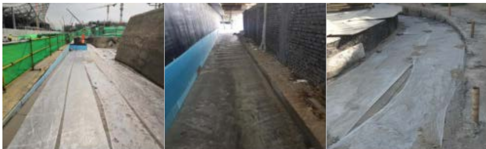
图 4-24 再生流态回填料（预拌流态固化土）
